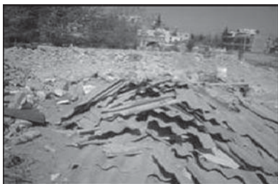
a. Asbestos mats
